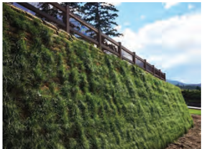
Mur de soutènement paysager de 5 m (16 pi) de hauteur
