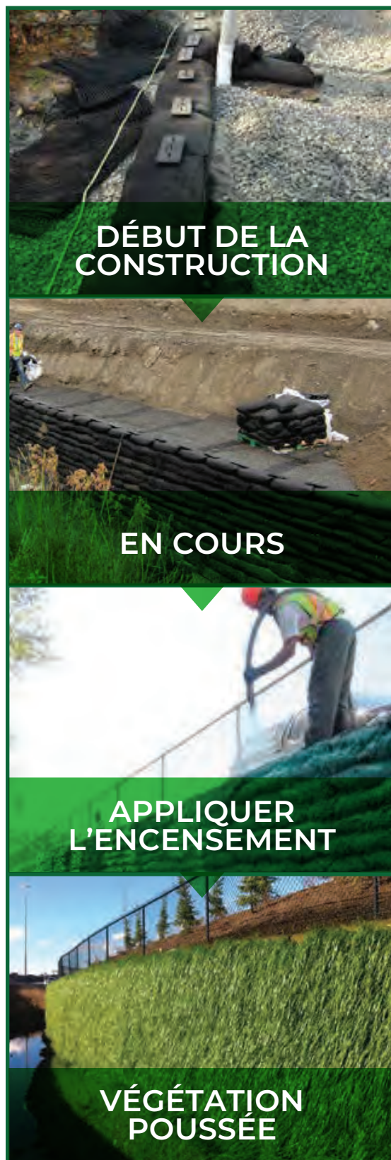
Mur de soutènement commercial de 5 m (16 pi) de haut
