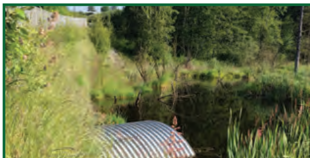
MURS DE PONCEAU VÉGÉTALISÉ
